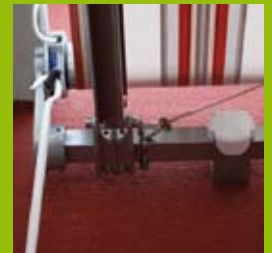
Detail uchytenia markízy do architektúry s použitím elektropohonu (markíza Stabil)
